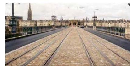
图 12 波尔多第三轨供电线路
